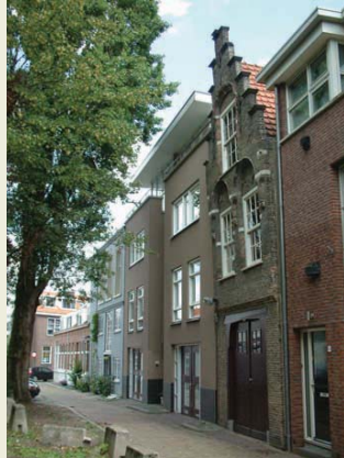
Schuitmakersstraat 12-14, architect A. Venema
