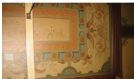
Detail plafond Wijnstraat 153
